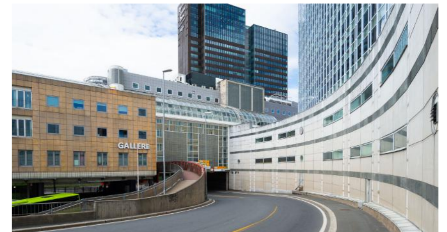
Nylandsveiens vestre rampe går under bygget, langs Plaza
