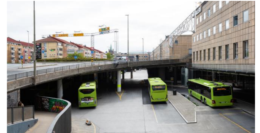
Oslo bussterminal ligger i første etasje og fyller bakkeplan
