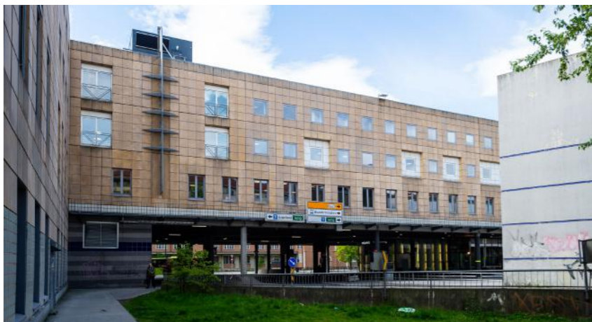
Nylandsveiens østre rampe går under bygget
