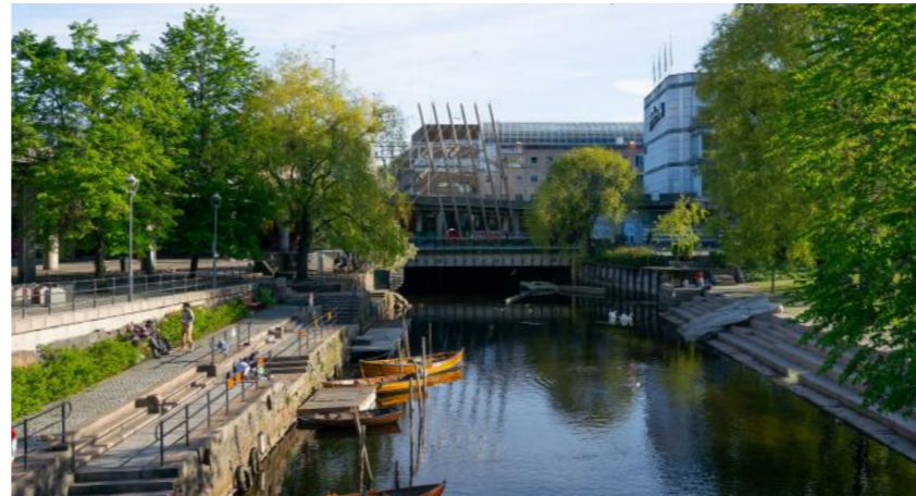
Kulverten til Akerselva går under bygget
