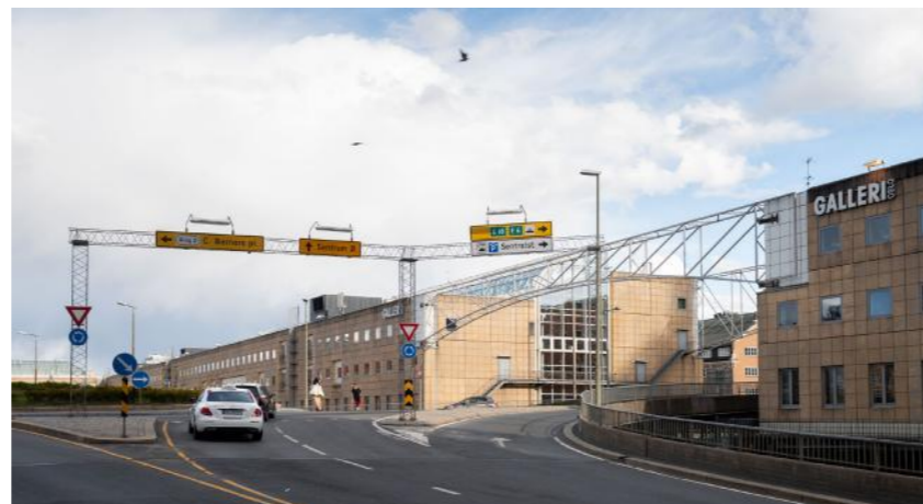
Nylandsveien deler bygget i to i de øverste etasjene
